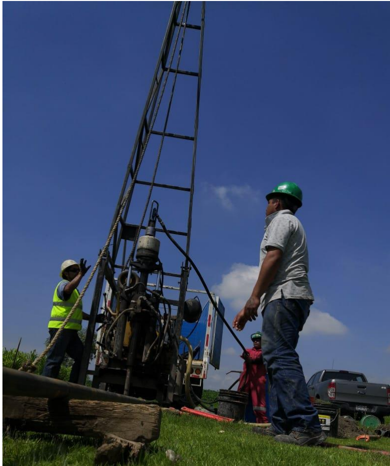
Ilustración 19 Sondeo de Penetración Standar, pozo no.2
